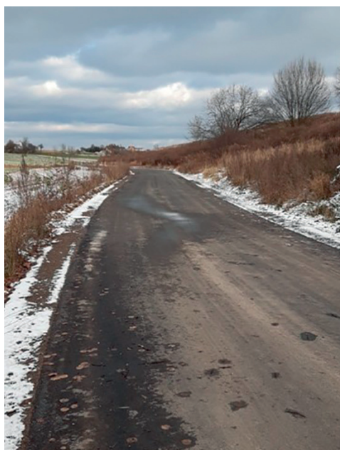
Droga DG 705039 S w miejscowości Wilków
