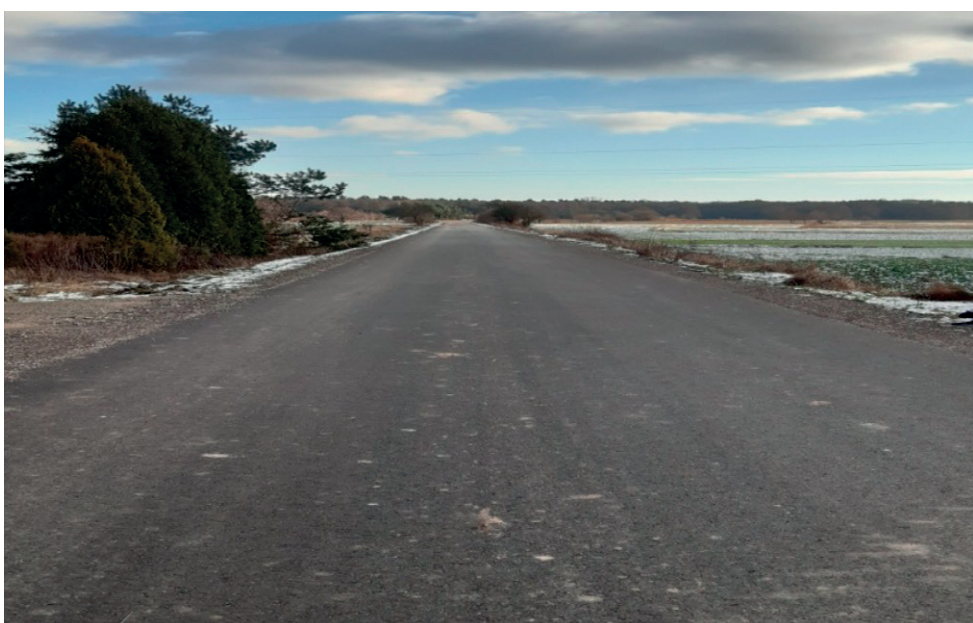
Droga DG 705035 S Wilków kolonia Fryszerka
