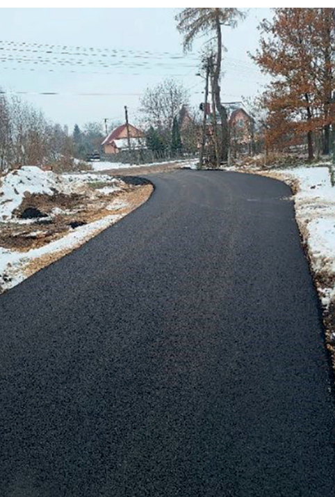
Droga dojazdowa do gruntów rolnych w miejscowości Sadowie
